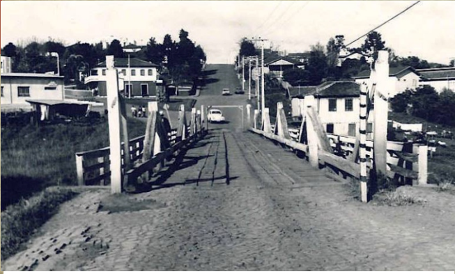
Ponte de acesso ao Hospital de Caridade e Maternidade Jonas Ramos.
